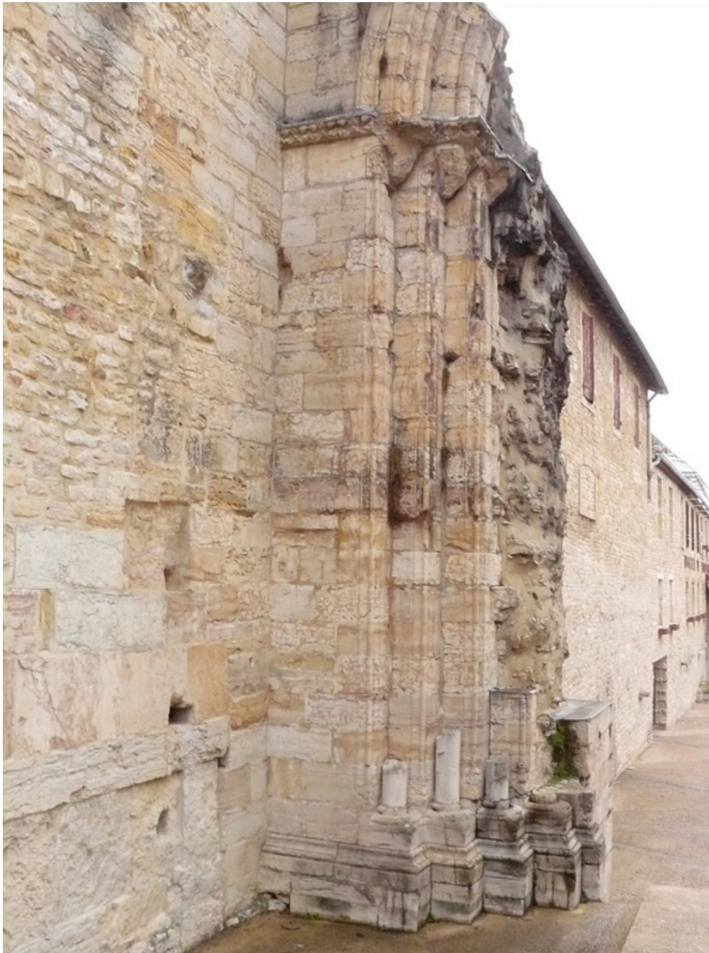
Fig. 4 - Cluny III, façade gothique, vestiges du piédroit gauche (cl. J. Rollier).
