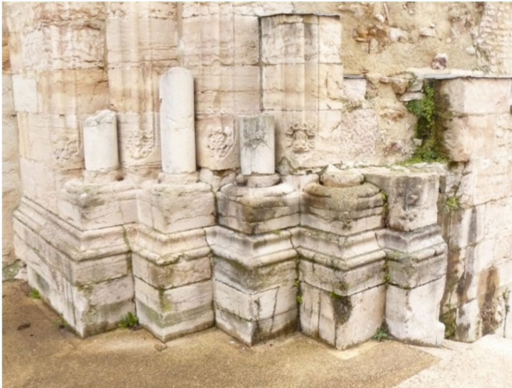
Fig. 5 - Cluny III, façade gothique, vestiges du piédroit gauche (cl. J. Rollier).
